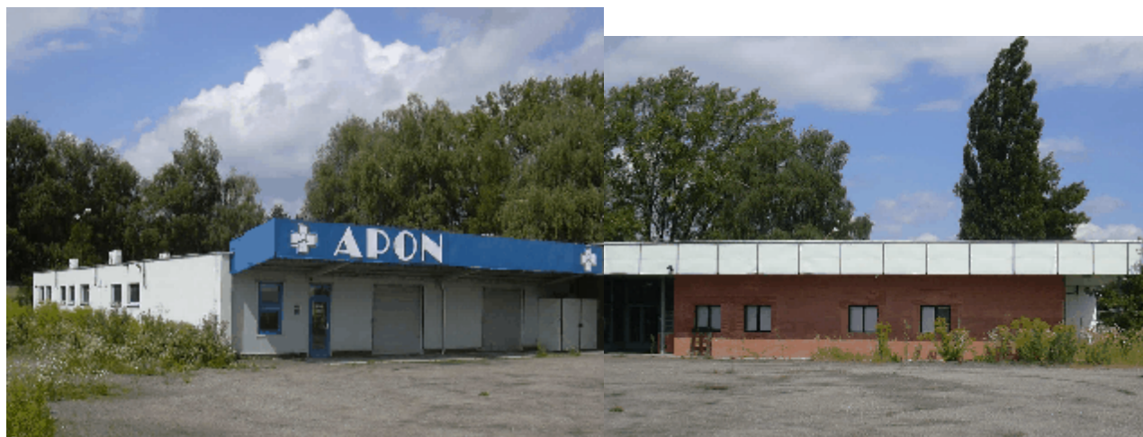
Vlevo budova č.p. 607 na p.p.č. 1096, vpravo původní část na p.p.č. 932
